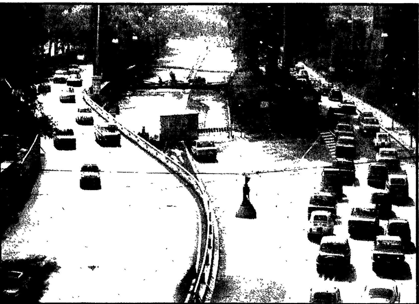
La strozzatura al Muro Torto provocata dai lavori per gli scivoli del parcheggio sotterraneo di Villa Borghese; qui saranno dirottati quando la villa sarà chiusa al traffico taxi e autobus che attualmente percorrono il «Muro»
