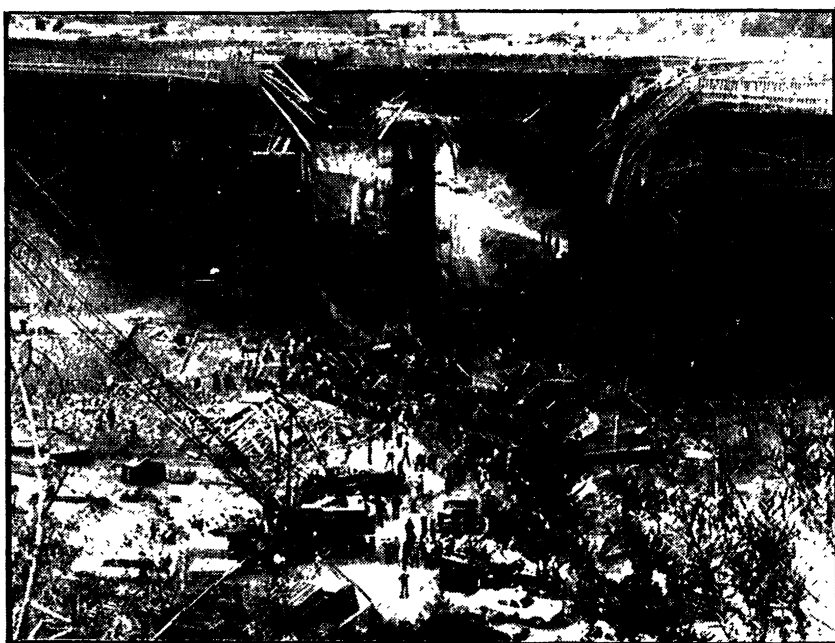
PASADENA — Sei persone travolte nel pauroso crollo di un ponte in California; i corpi di due di essi sono ancora sotto le macerie, mentre altri vennero lavorati e sono rimasti gravemente feriti. E' questo il tragico bilancio di una sciagura sul lavoro avvenuta mentre si costruiva un viadotto su una rampa di uscita di una nuova autostrada destinata a collegare il centro di Pasadena con la periferia. Le macerie hanno travolto gli operai che si trovavano sopra e sotto il ponte. I vigili del fuoco e numerose squadre di volontari hanno lavorato a lungo per recuperare i corpi dei morti e dei feriti. E' questo il sesto crollo in due anni che si deve registrare in California durante la costruzione di strutture stradali. Nella foto: le squadre di soccorso lavorano fra le macerie del viadotto crollato per recuperare i corpi di morti e feriti
