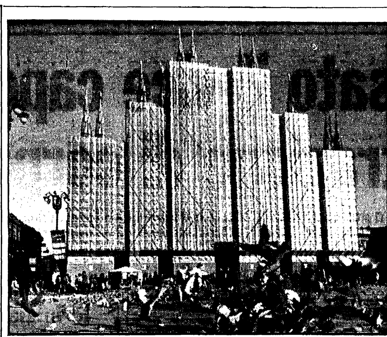
MILANO — Così si presenta da ieri il Duomo, che probabilmente manterrà questo singolare aspetto per due anni. E' stata, infatti, completamente coperta con teli di plastica bianca la facciata ormai seriamente corrosa dallo smog.
