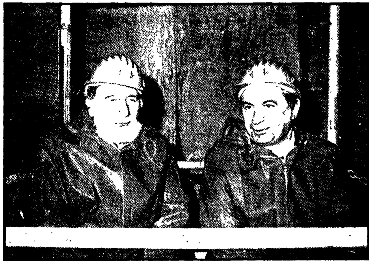
Darida e Bozzi nel tunnel della metropolitana
