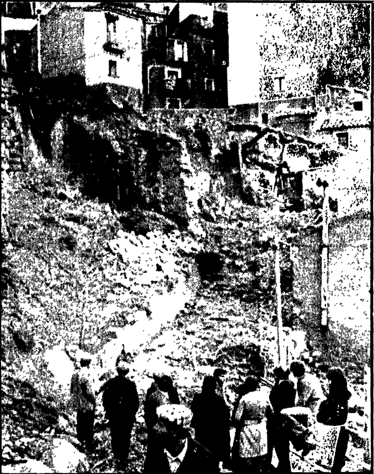
Il paese siciliano di Nicosia. Gli abitanti lo hanno abbandonato per il verificarsi di continui crolli dovuti alle frane
