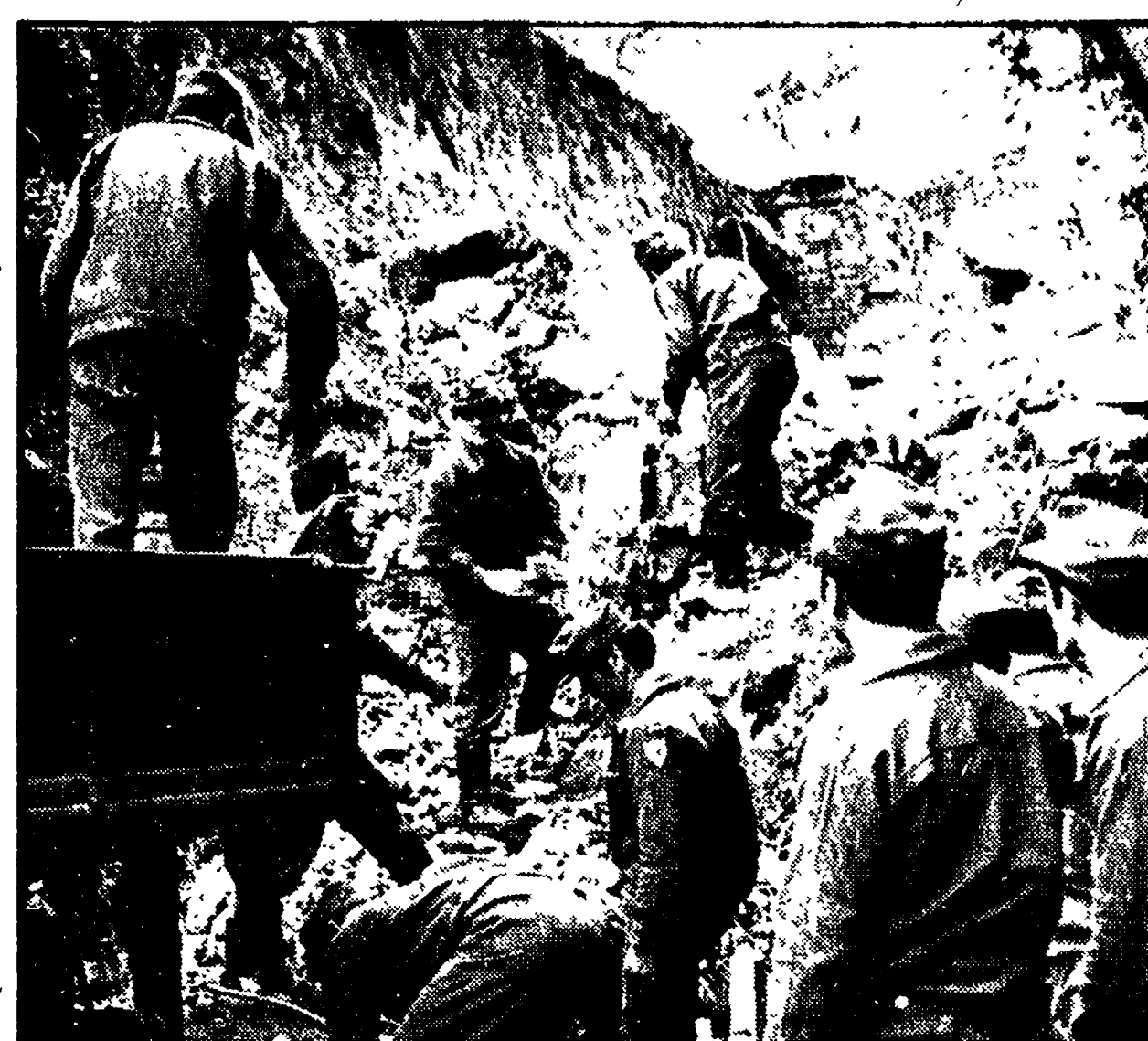
I vigili al lavoro per sgomberare la massa di detriti abbattutasi sulla palazzina al Gianicolense; per qualche ora si è temuto che delle persone vi fossero rimaste sepolte
