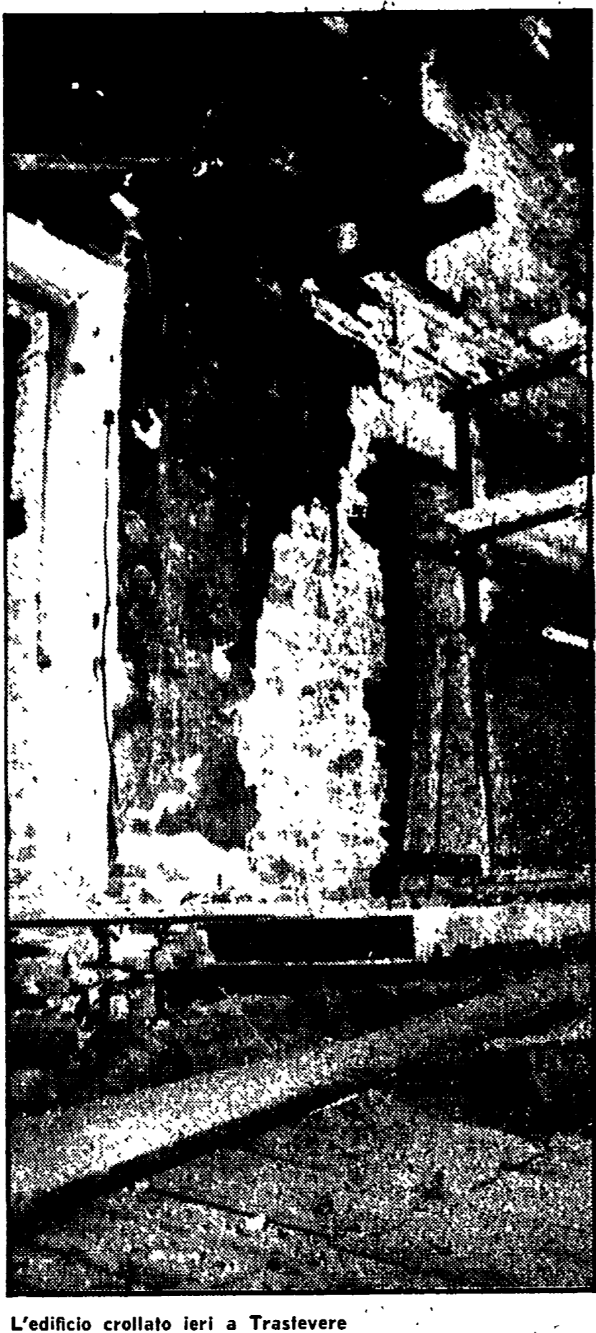
L'edificio crollato ieri a Trastevere
