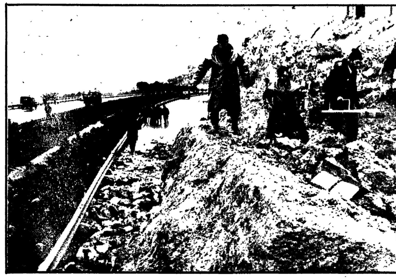
NEL CUBA FOTO: un aspetto della curva interrotta dalla gigantesca frana.
