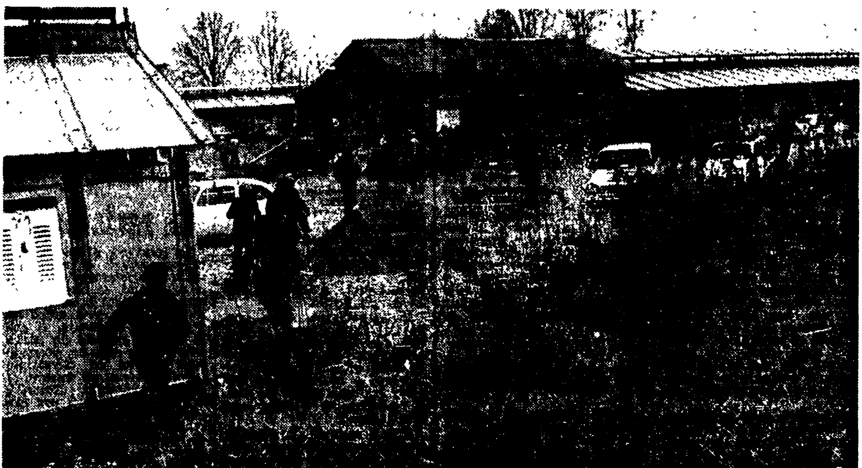
CAORSO — I lavoratori del cantiere dell'ENEL in fila per il primo turno di mensa. A sinistra e sul fondo si vedono le baracche dove la maggior parte di loro è costretta a vivere. Nel paese, che è lontano qualche chilometro, gli affitti sono aumentati del 60% ed ora non ci sono più vani abitabili. Il Comune di Caorso chiede che l'ENEL e lo Stato contribuiscano a sanare almeno questi problemi più urgenti.
