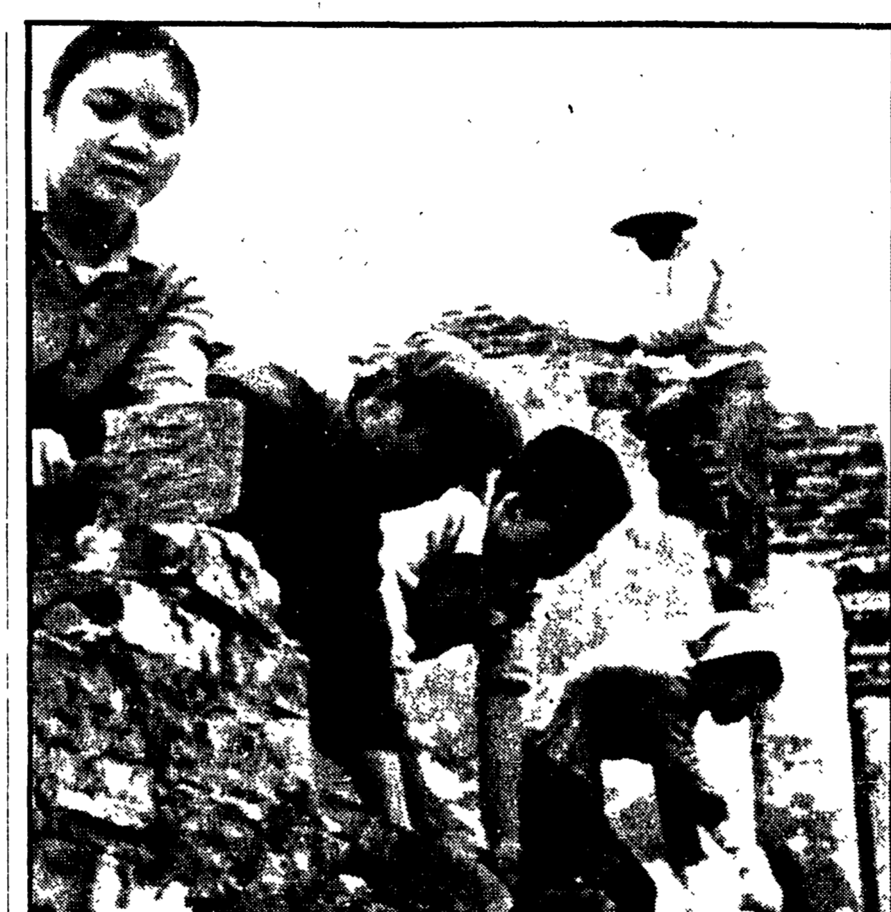
HANOI - Lavoratori, giovani, donne della capitale nord-vietnamita impegnati nell'opera di ricostruzione dei quartieri devastati dai bombardamenti americani
