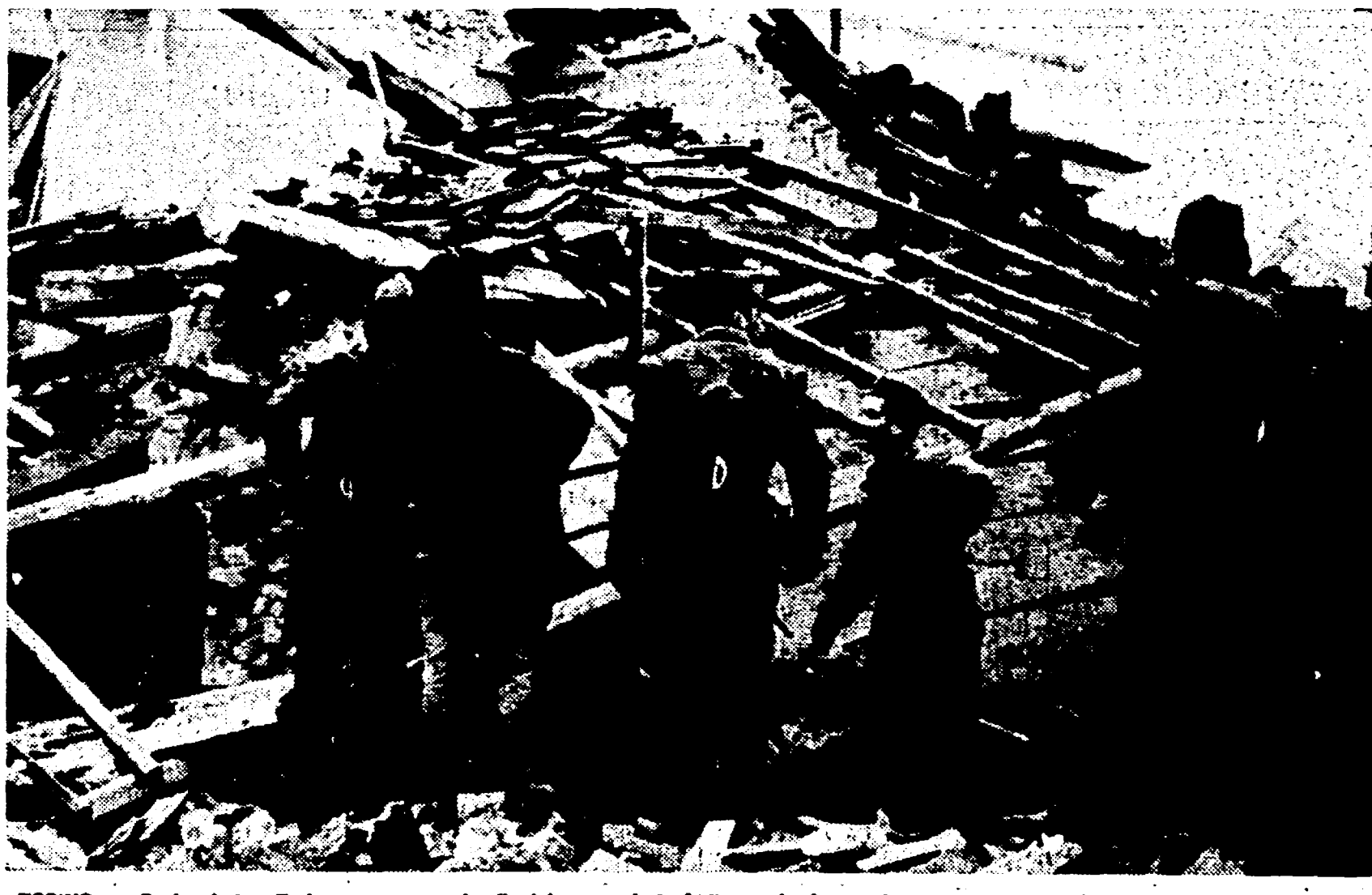
TORINO — Panico ieri a Torino per una serie di violente esplosioni di gas che hanno devastato case e strade in una popolosa zona della città e nelle vicinanze della «città nuova», a Collegno e Rivoli in particolare. Inquadrati i danni; cinque le persone gravemente ustionate e numerosi i feriti. Nella foto: una casa creata a Collegno per l'esplosione del gas. (IL SERVIZIO A PAGINA 6)
