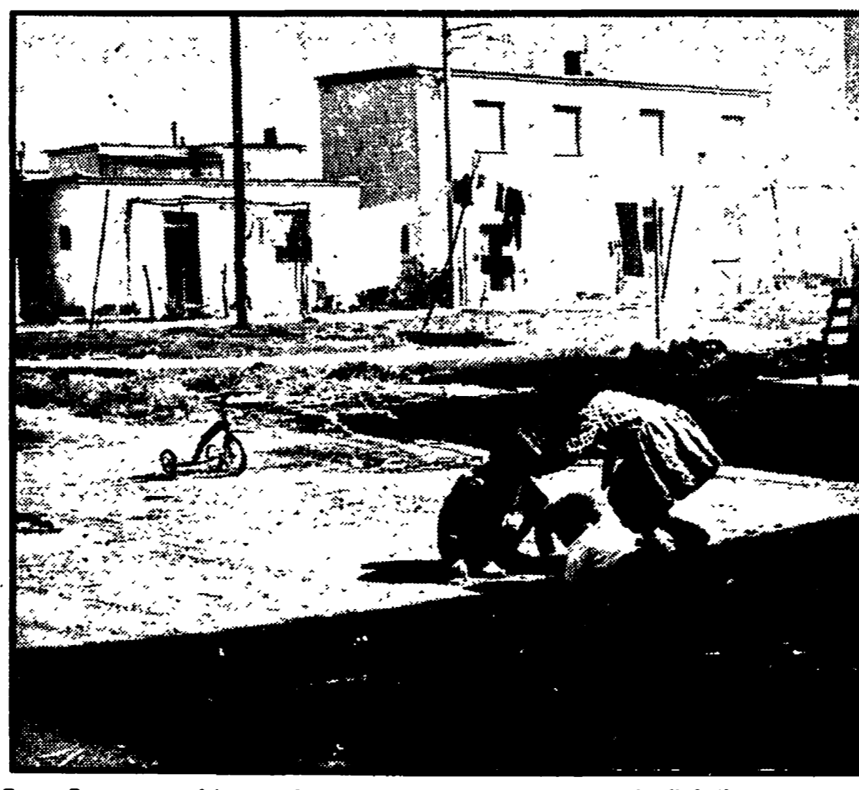
Borgo Grappa, uno dei tanti che sorgono attorno al nucleo centrale di Latina
