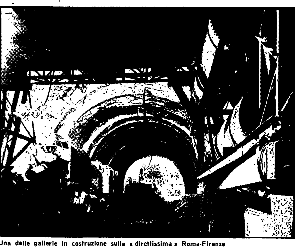
Una delle gallerie in costruzione sulla «direttissima» Roma-Firenze
