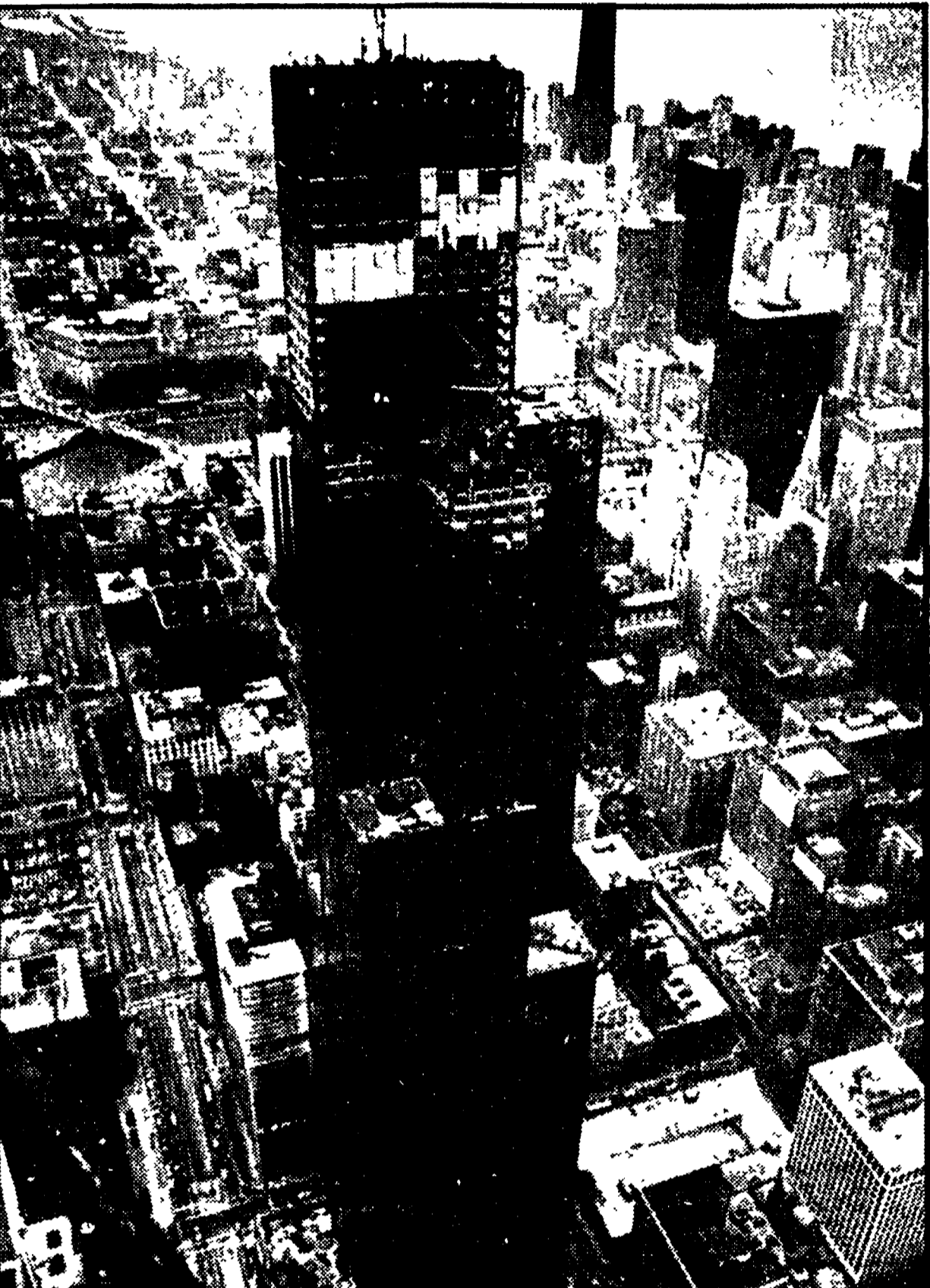
CHICAGO — Il più alto edificio del mondo sta per essere completato. E' un grattacielo di 435 metri che con l'antenna TV supera la quota dei 500 metri e che è suddiviso in 110 piani. Entrerà in funzione entro il 1974. Il costo globale della « torre » è di 150 milioni di dollari
