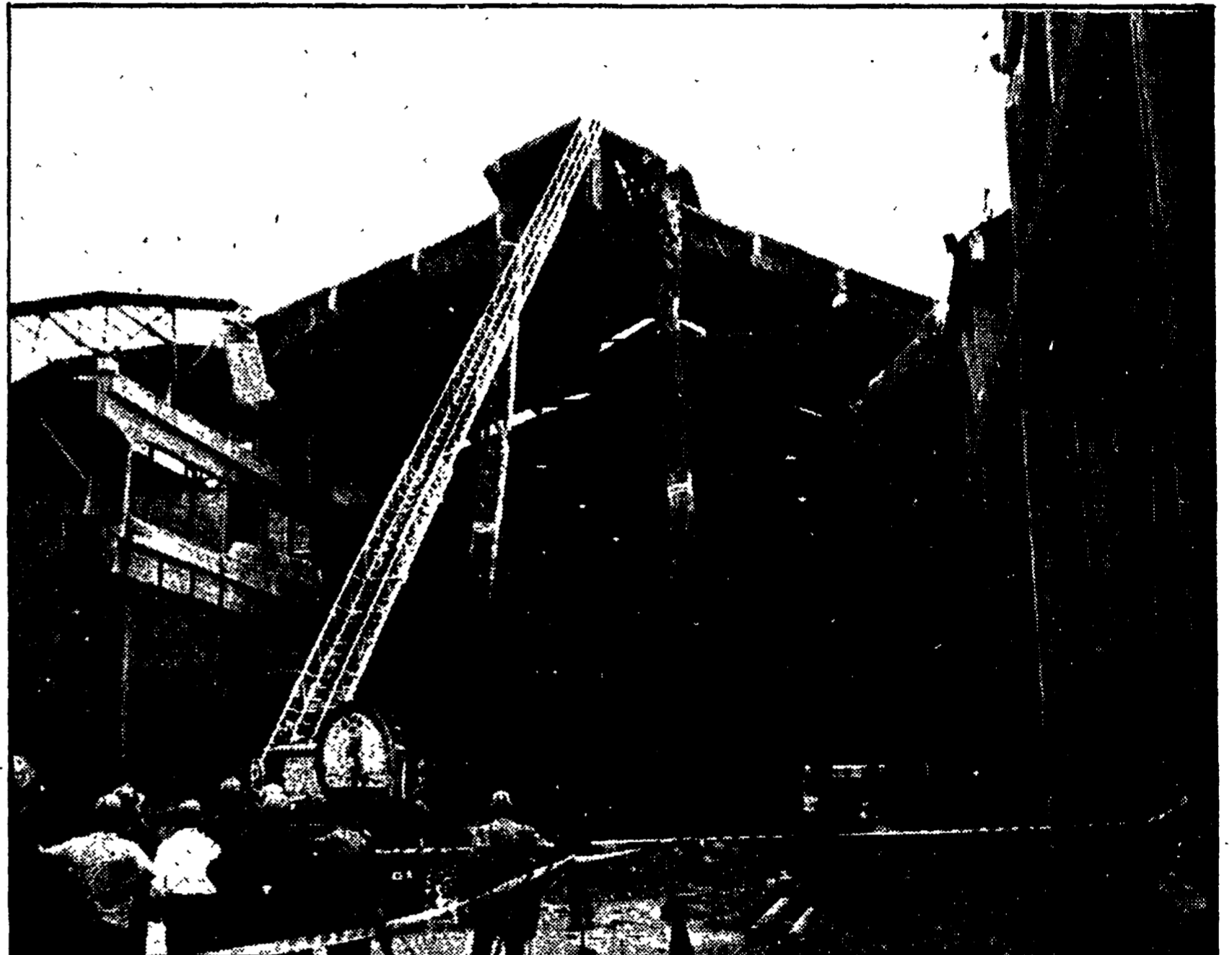
Tre operai sono morti alle Acciaierie di Terni: stavano lavorando sul tetto di un vecchio capannone che doveva essere demolito quando la faliscante costruzione ha ceduto. I tre - Lanfranco Belli, Giovanni Campana e Giuseppe Padavini - sono precipitati nel vuoto da un'altezza di venticinque metri: schiacciati dal cemento armato e dai massi, sono rimasti uccisi praticamente sul colpo. Pronto è stata la reazione di tutti gli operai del complesso siderurgico: è stato sospeso il lavoro; per oggi sono previste interruzioni del lavoro ed assemblee. Il gravissimo triplice omicidio bianco ripropone il problema delle ditte appaltatrici (i tre infatti erano alle dipendenze di una ditta che aveva subappaltato i lavori di demolizione) e le gravissime responsabilità delle aziende dell'IRI in questo campo. Nella foto: il capannone della tragedia A PAGINA 6
