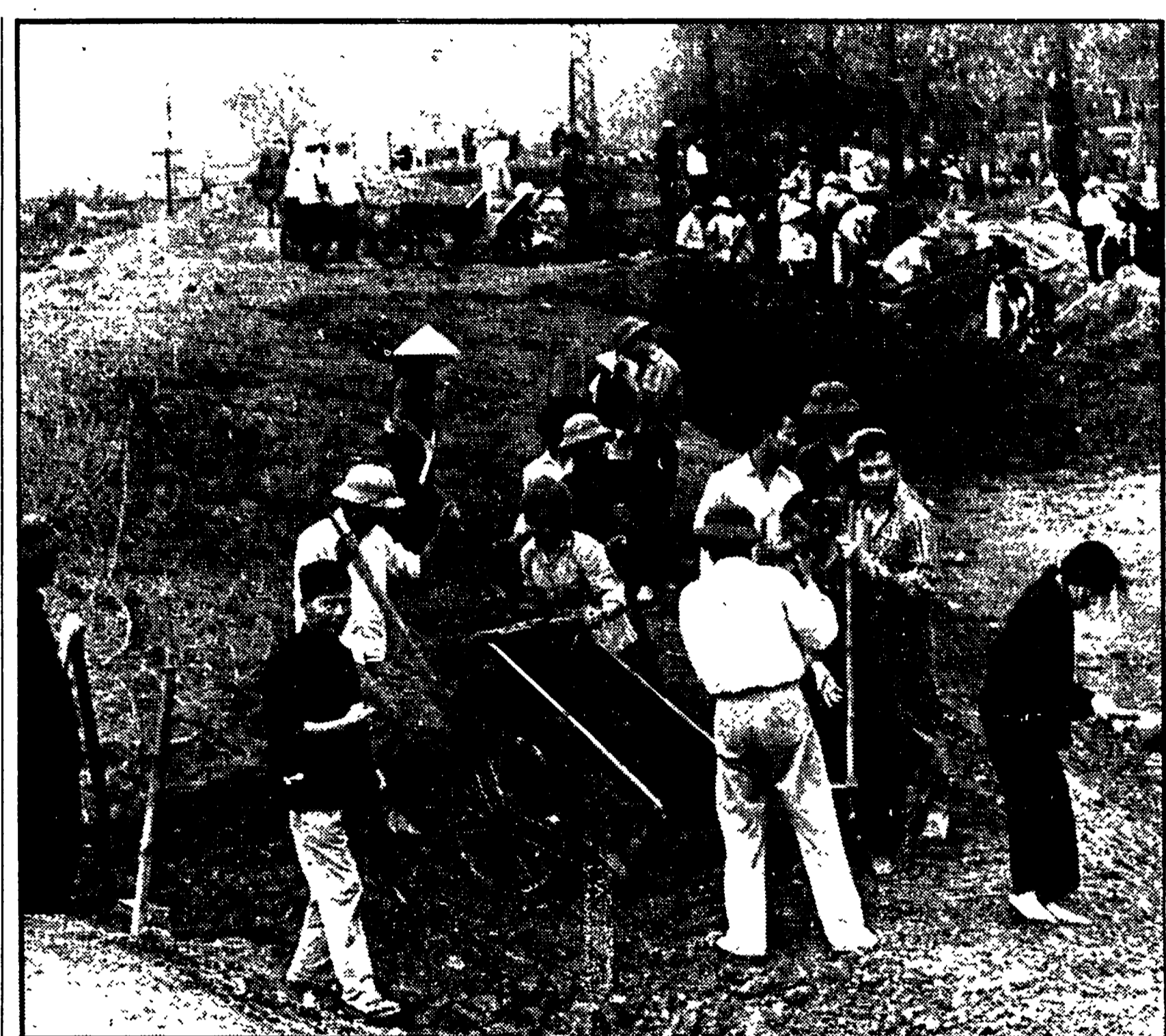
REPUBBLICA DEMOCRATICA DEL VIETNAM — Uno dei tanti cantieri dove uomini e donne lavorano per porre riparo agli immensi danni creati dalla guerra
