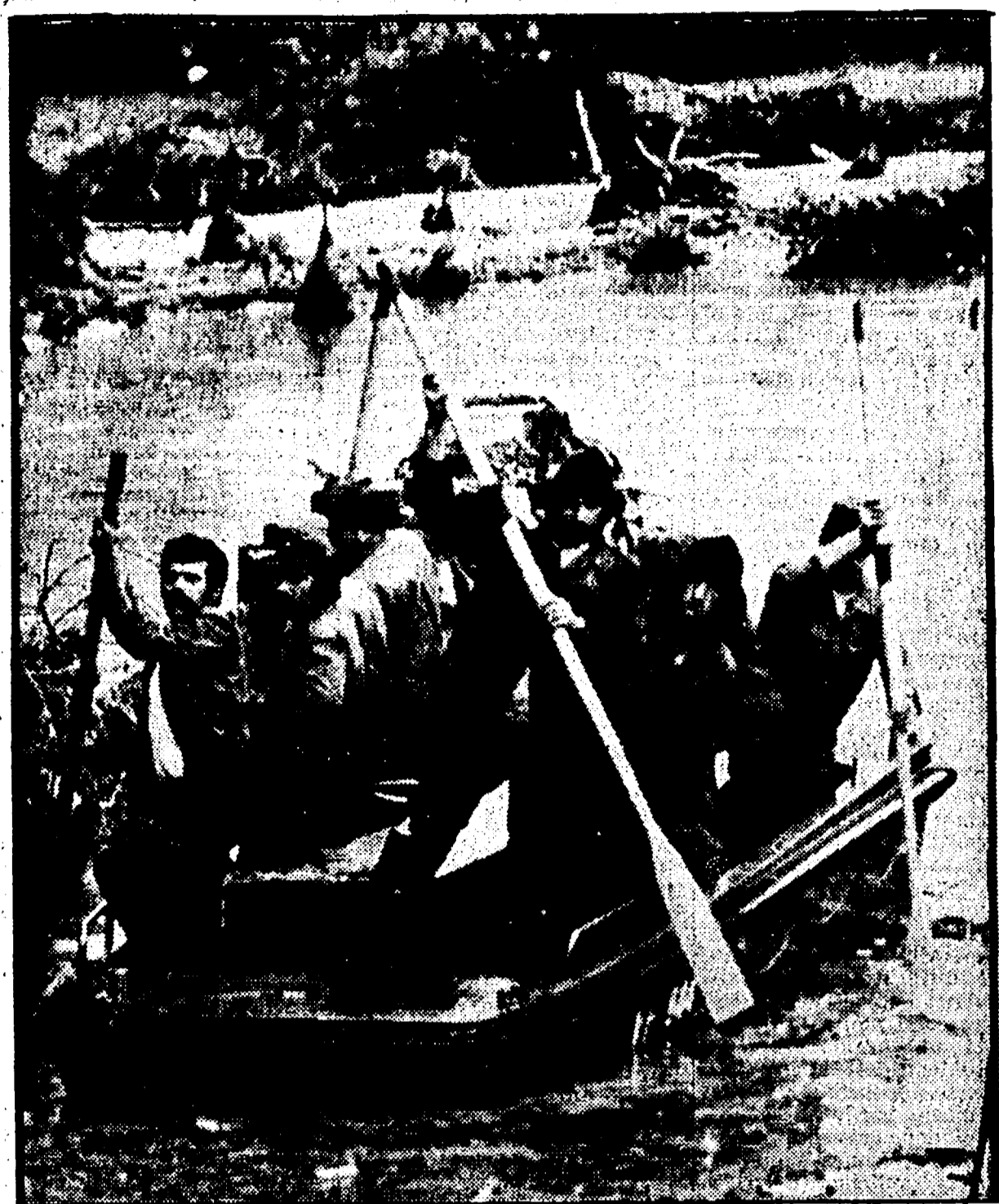
Disastroso nubifragio, la scorsa notte, a Reggio Emilia e in decine di comuni della provincia. In primo piano bilancio parziale di miliardi di danni alle colture e di due morti e 60 feriti. Alcuni ponti sono crollati, molte strade risultano bloccate da frane e smottamenti mentre un'auto è, probabilmente, finita in un fiume. A Reggio città, nel quartiere S. Pellegrino, 100 mila metri cubi di acqua, uscita dal torrente Crostolo in piena, hanno invaso e sommerso decine di case. Nel cuore della notte drammatici salvataggi sono stati effettuati da vigili del fuoco, polizia e carabinieri. Sul posto si sono recati immediatamente il sindaco di Reggio e il presidente della Giunta regionale compagno Fanti. Intanto nell'astigiana, colpito l'altro giorno, una grandinata che ha provocato 5 miliardi di danni, si stanno svolgendo assemblee e incontri per far fronte alla situazione. A PAG. 5
