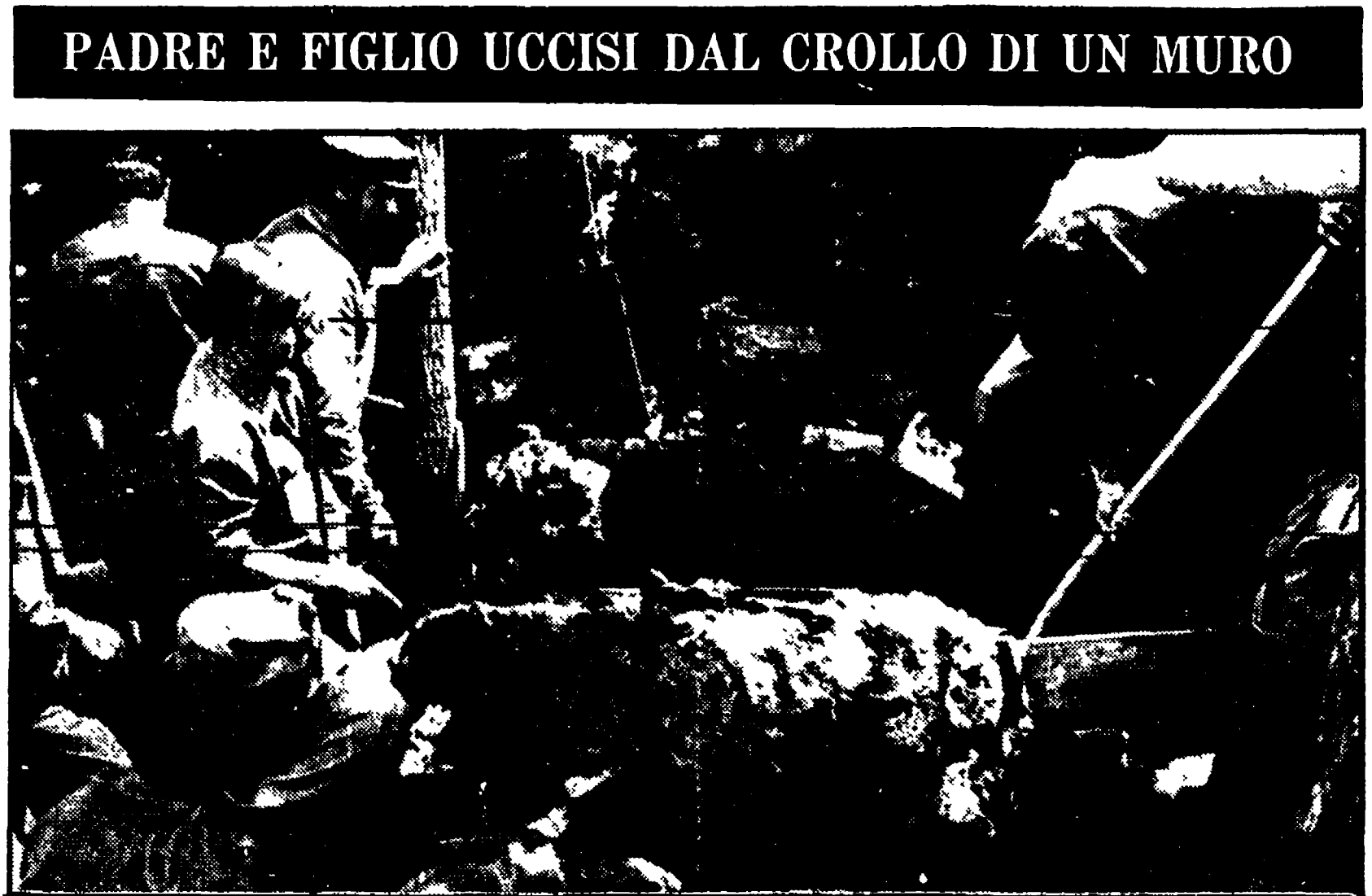
TORINO - Sono morti, padre e figlio, e la madre è gravemente ferita. La tragedia è avvenuta sulle colline di Torino: le vittime, Luigi, il padre, e Franco Banchiero, avevano deciso di riparare il muro che sosteneva un terrapieno pericolante...
