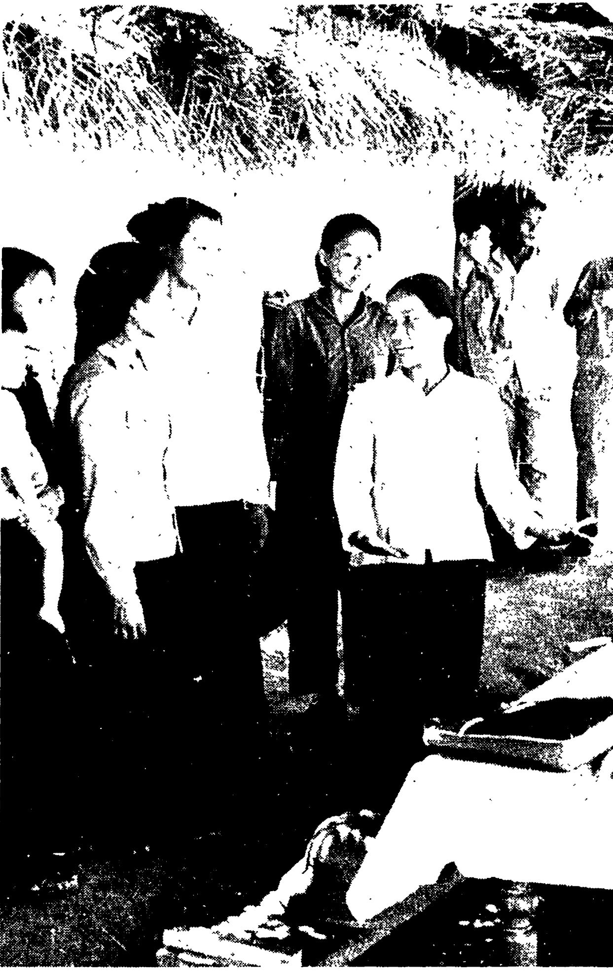
Una squadra di donne che partecipa ai lavori di riparazione del ponte di Cup.
