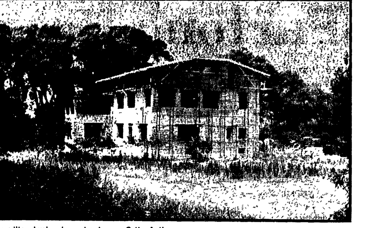
Una villa abusiva in costruzione a Ostia Antica
