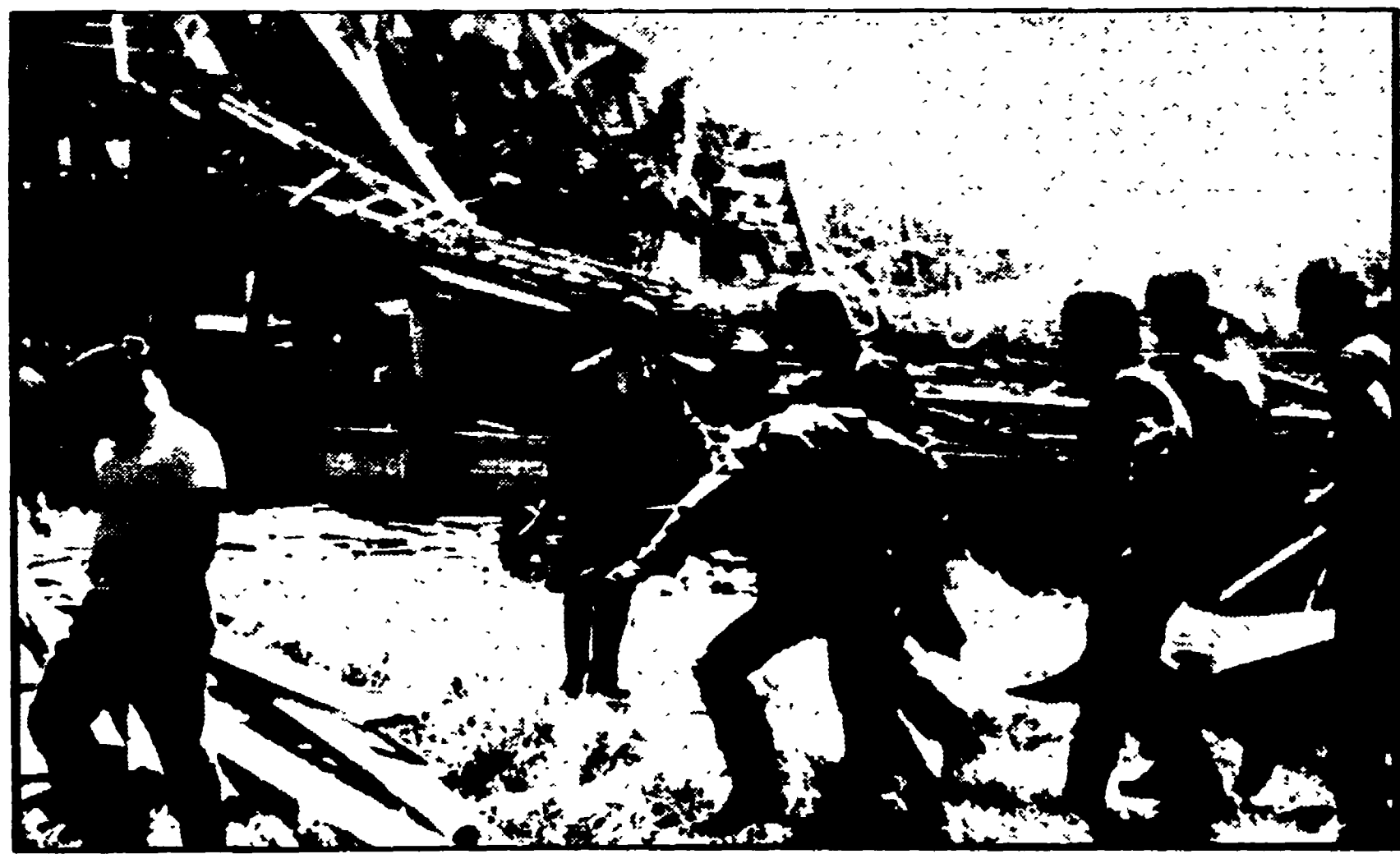
Tragedia sul lavoro a Villafranca in provincia di Torino: il crollo delle strutture di un capannone in costruzione ha travolto un gruppo di operai che sono rimasti sepolti dalle macerie. I morti sono tre e i feriti quattro, ma in condizioni gravi. La morte dei tre lavoratori ha provocato profonda emozione in tutta la zona. I sindacati hanno proclamato uno sciopero di protesta. NELLA FOTO: vigili del fuoco e soccorritori trasportano una delle salme
