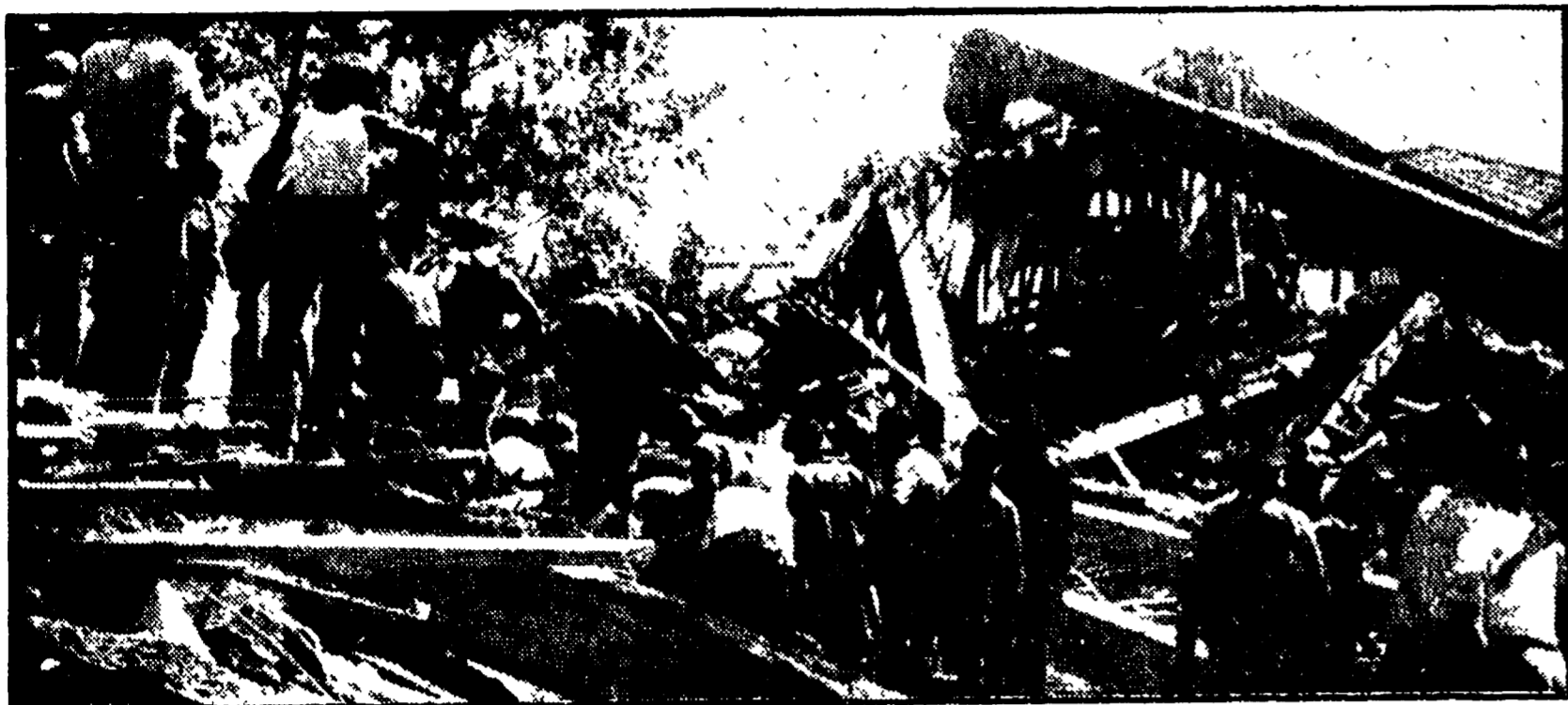
TORINO — Squadre di vigili del fuoco al lavoro tra le macerie del capannone crollato
