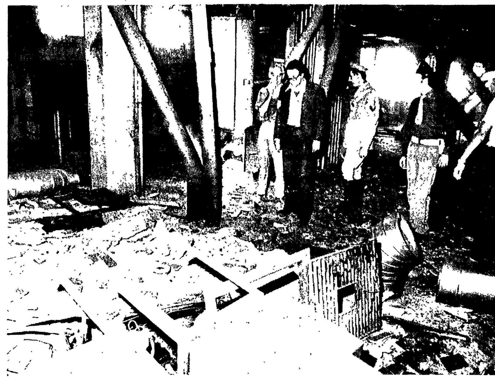
GENOVA — L'interno del silo devastato dallo scoppio, così come è apparso ai primi soccorritori.
