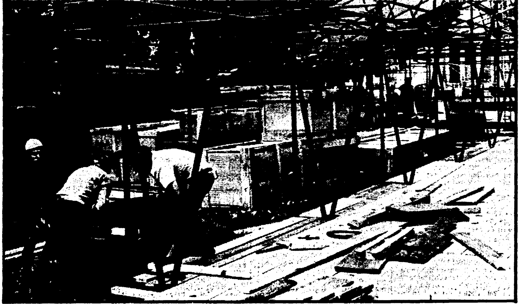
Con una grande manifestazione antifascista promossa dalla FGCI si apre fra sei giorni a Milano il Festival nazionale dell'Unità. Il Parco Sempione, che ospiterà la cittadella della stampa comunista, è in queste ore tutto un cantiere. Nella foto: una squadra di operai monta uno dei padiglioni della Polonia. A PAGINA 6 IL PROGRAMMA DEL FESTIVAL E LE NOTIZIE
