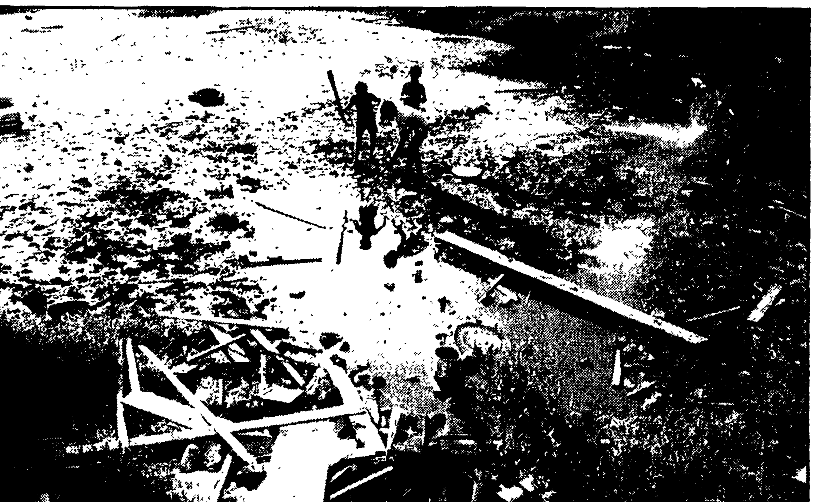
Nuova Magliana: la buca di un cantiere che ha dovuto sospendere i lavori si è trasformata in un deposito di acqua putrida e maledorante
