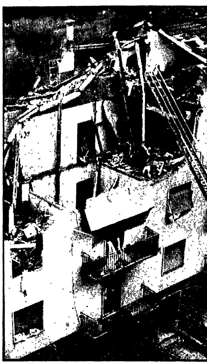
PRATO, 22. — Una terrificante esplosione è avvenuta oggi alle 13 in una stabile di via Cianuzano a Prato, provocando la morte di tre persone.
