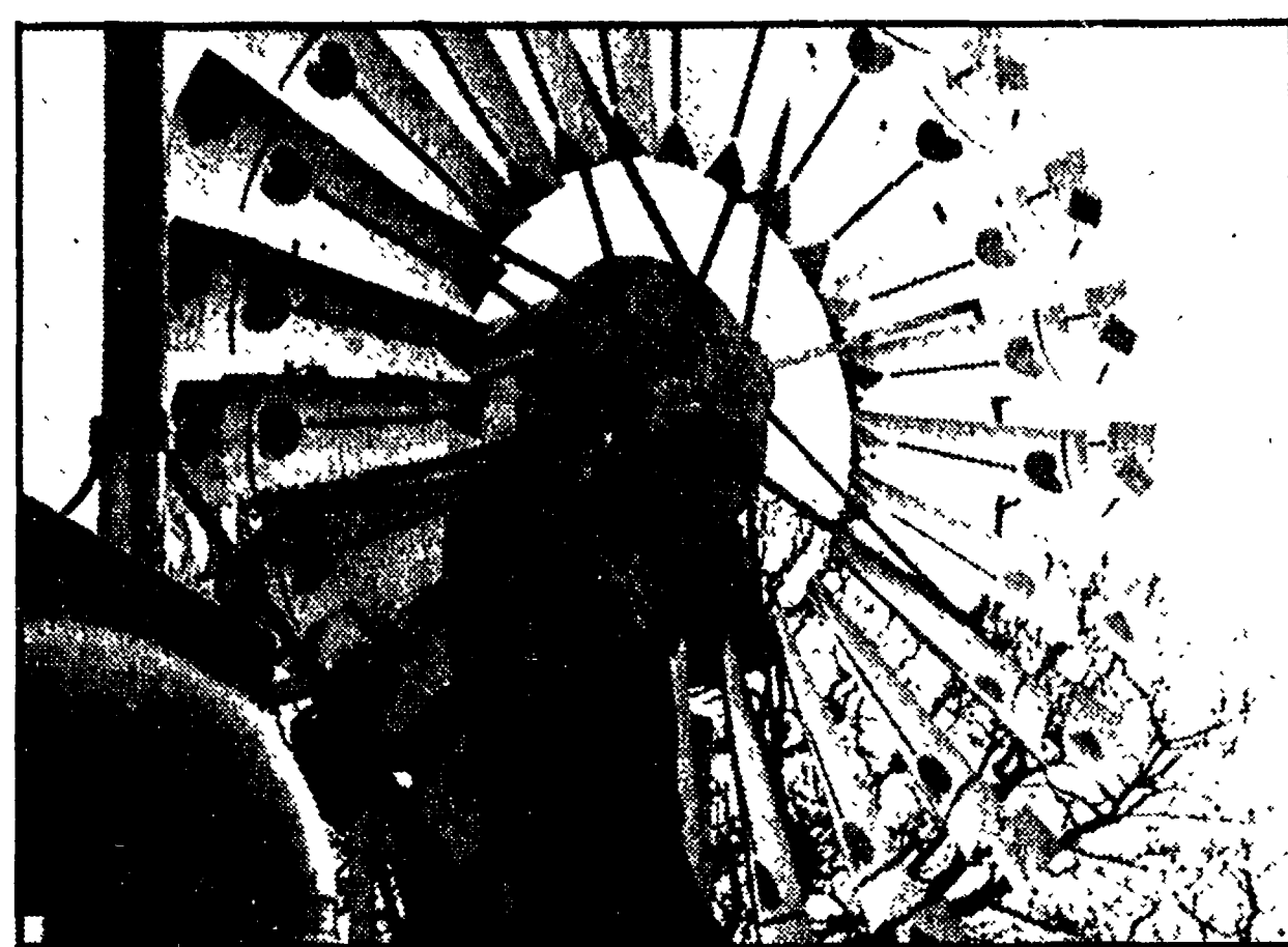
ENERGIA DAL VENTO. L'ingegnere Signor Arnold Stea, londinese, ha risolto per conto suo la crisi dell'energia installando sul tetto di casa una grande ventola che alimenta un generatore di elettricità, ricavandone una potenza di 5 hp. Quando cade il vento resta filosoficamente al buio
