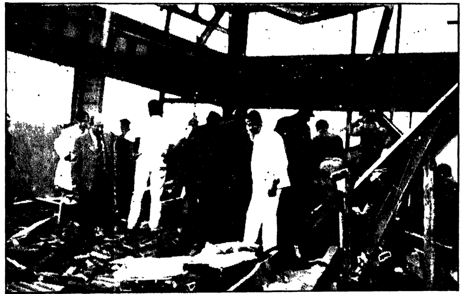
ASSISI - Magistrati, tecnici e soccorrittori sul posto della sciagura
