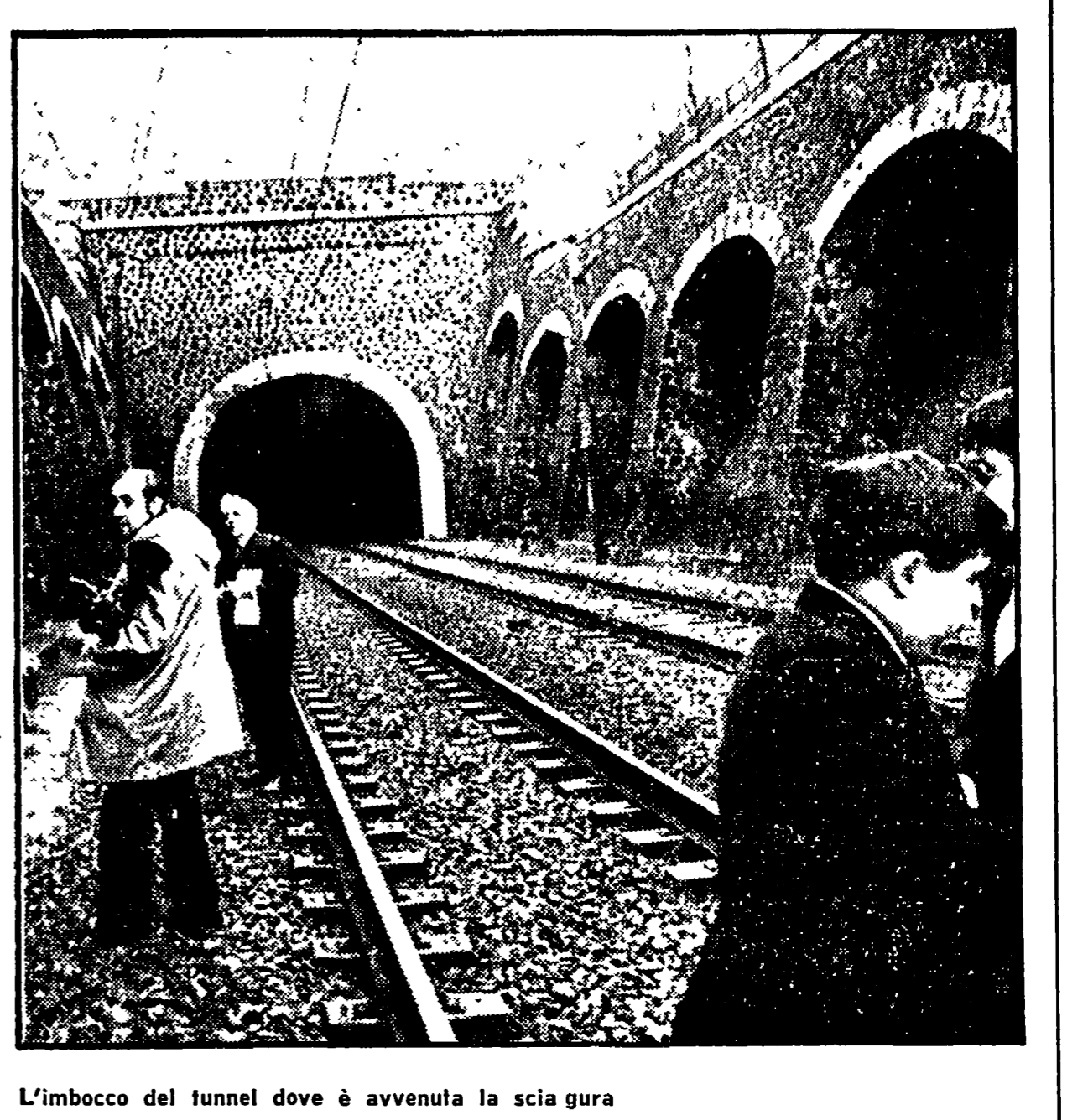
L'imbocco del tunnel dove è avvenuta la scia gura
