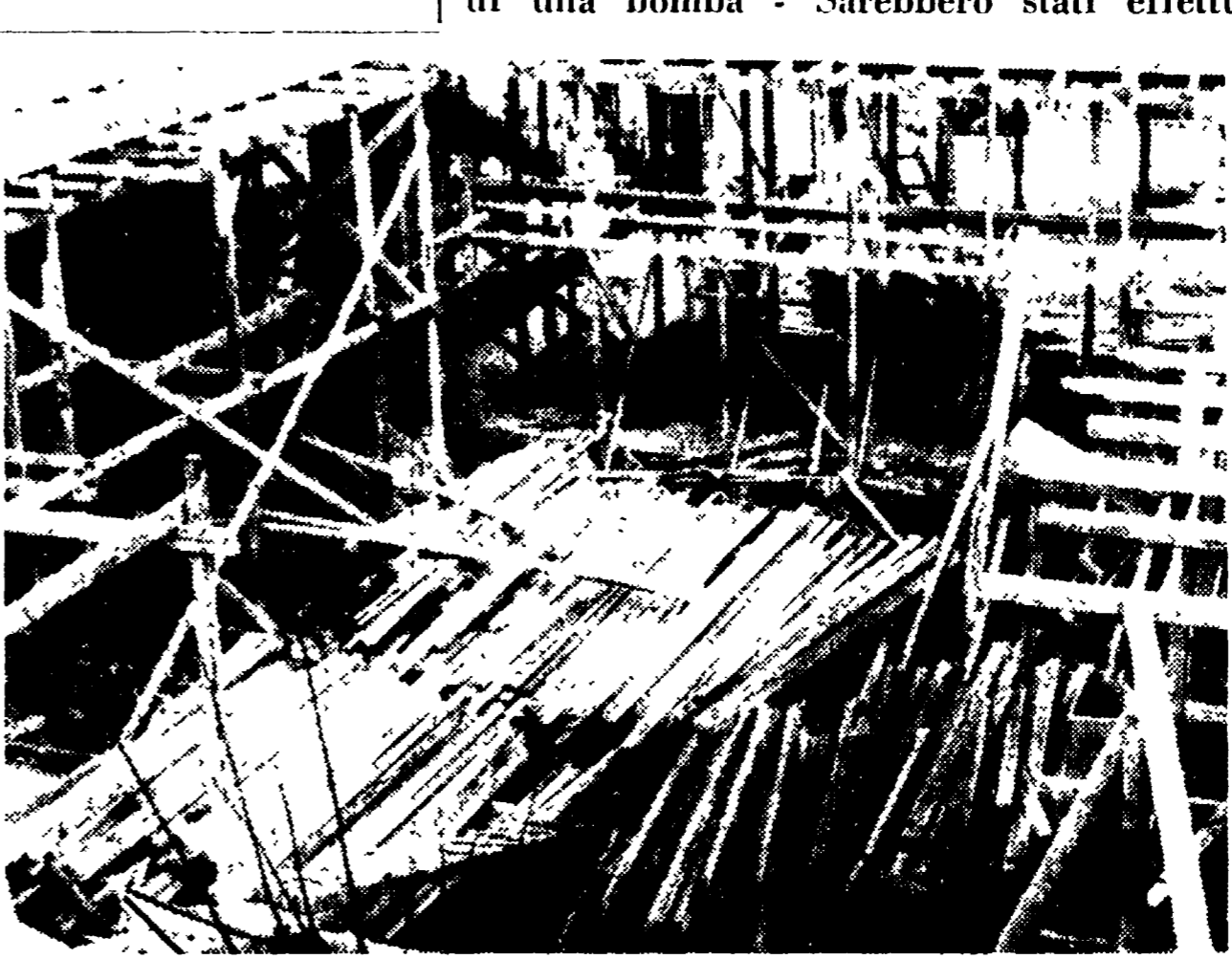
ATENE — L'impalcatura crollata.
