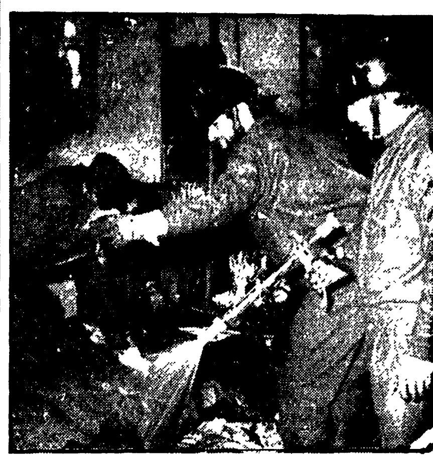
Vigili del fuoco rimuovono le macerie del rogo nel negozio della Magliana
