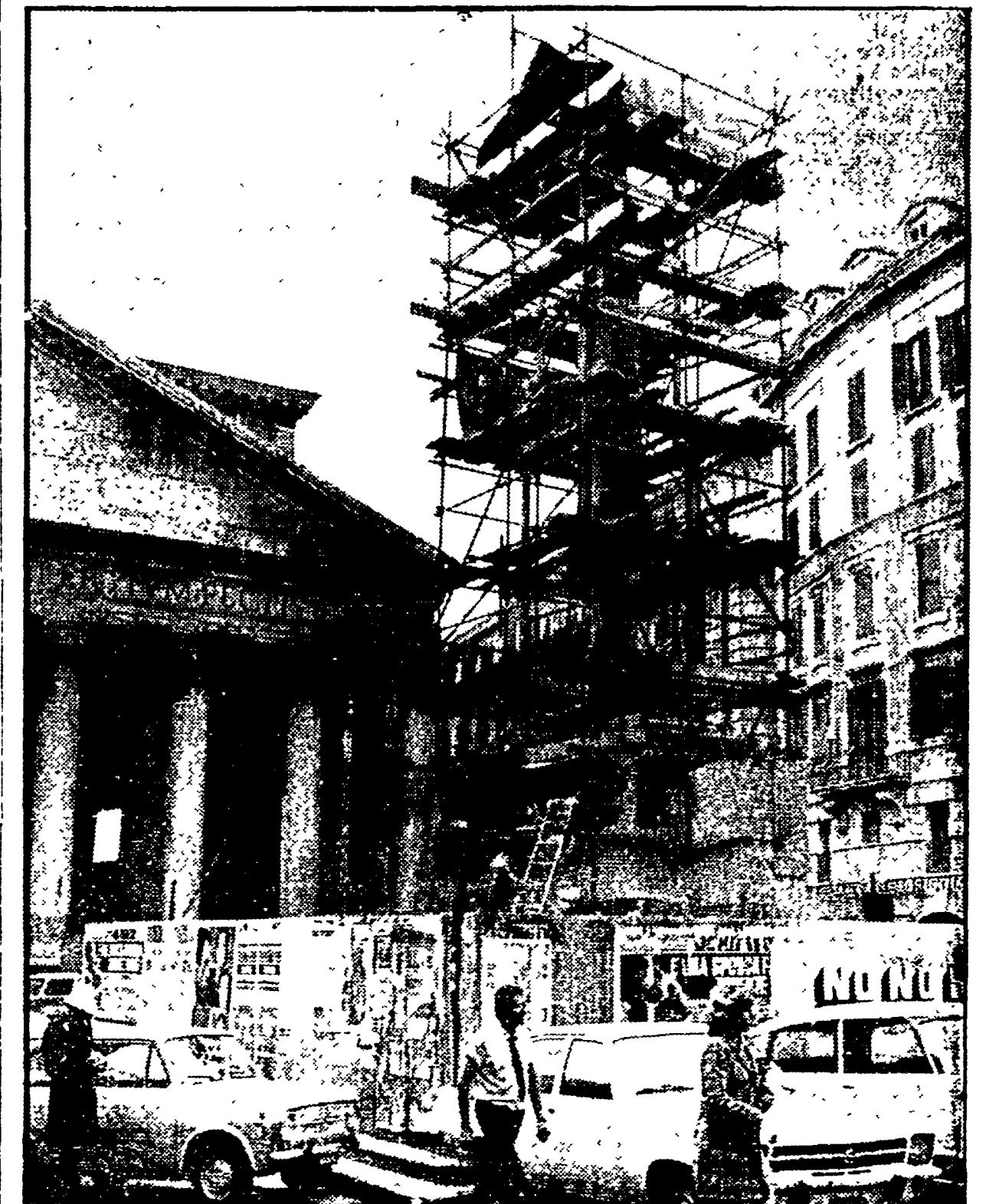
L'obelisco del Pantheon, ormai da molti mesi, è ancora «sospeso» nel vuoto. Con una nuova tecnica — una «fasciatura» di tubi Innocenti — si è riusciti a lasciare al suo posto il troncone finale del monumento, asportandone solo la parte inferiore. Il provvedimento si è reso necessario per evitare il crollo dell'obelisco. Infatti, in seguito alle vibrazioni causate dal traffico e all'erosione del tempo e dello smog la struttura interna e le iscrizioni egiziane al base sono definitivamente rovinate. Dopo questo intervento, che consisterebbe in una iniezione di cemento e in una delicata opera di restauro l'obelisco potrà tornare a essere visto «intero» dai romani. Nella foto: l'obelisco sospeso a mezz'aria
