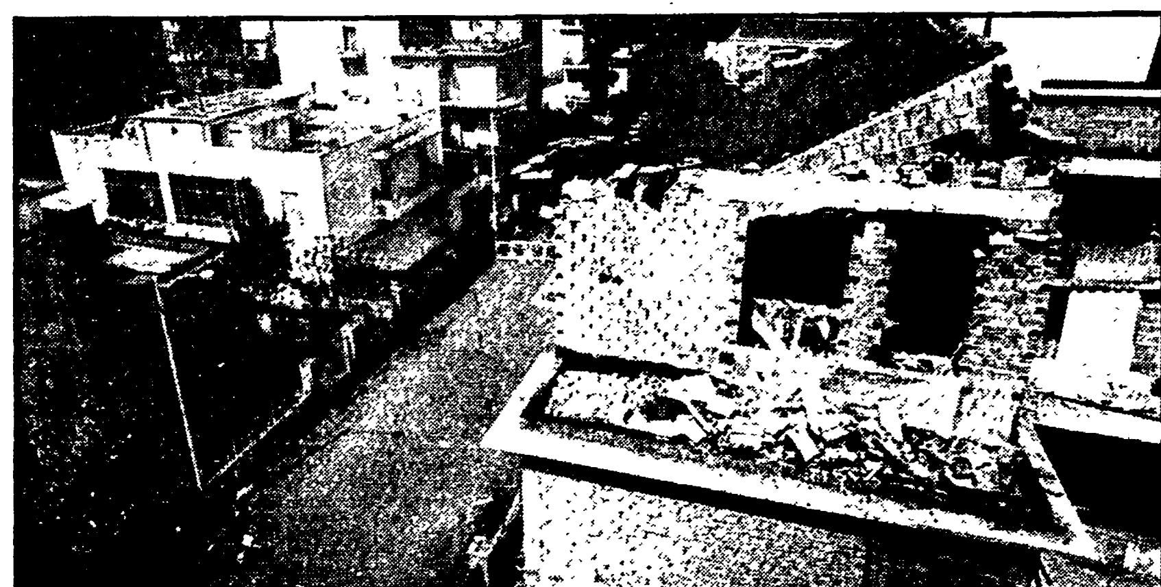
La sopraelevazione abusiva sul tetto dell'asilo in via Poggio Bracciolini, parzialmente crollata
