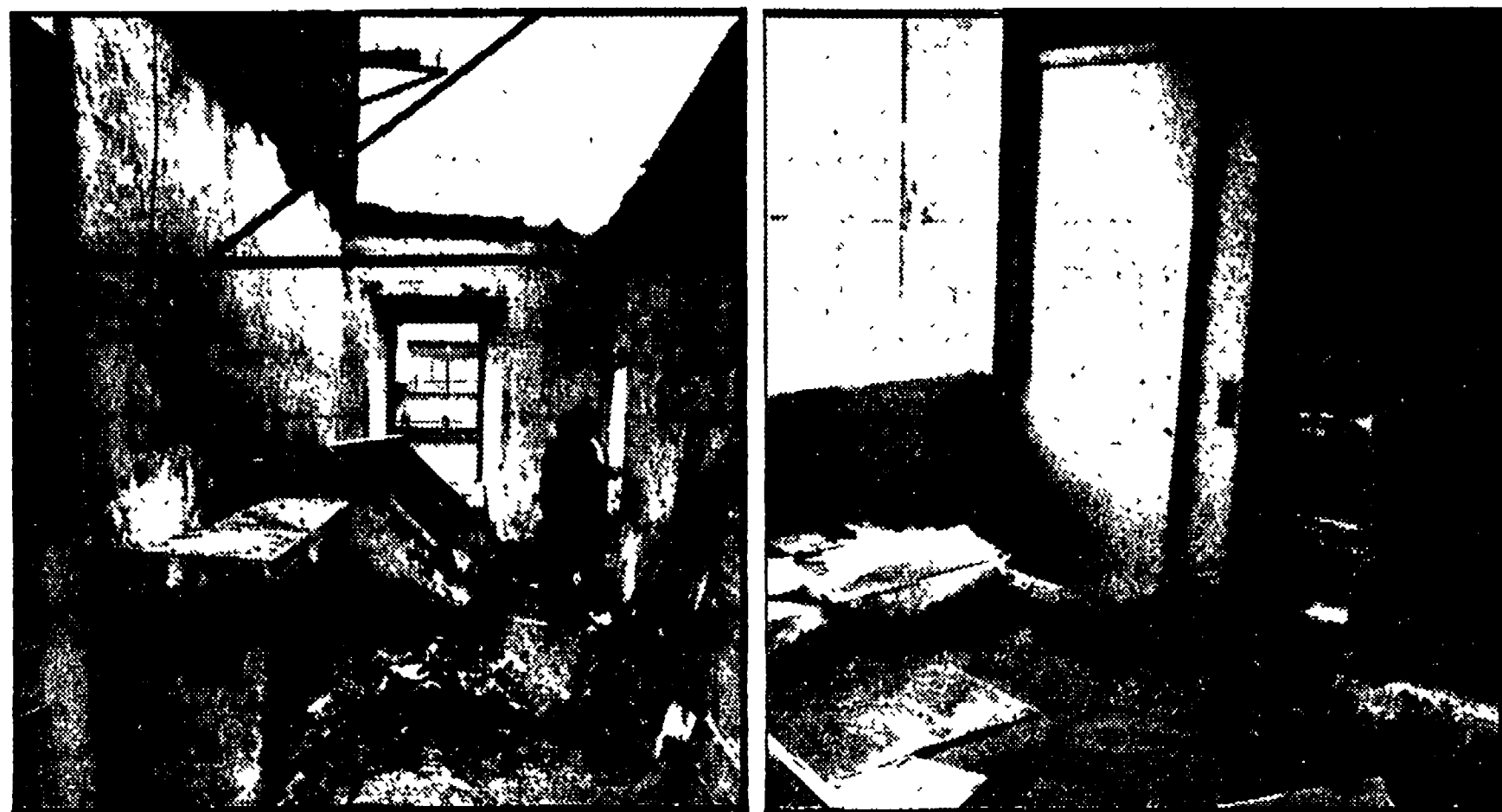
Una parte del tetto dell'edificio del Comune sprofondato in seguito all'incendio e, A DESTRA, uno degli uffici dell'archivio con, sullo sfondo, l'armadio che è stato forzato per rubare alcuni documenti
