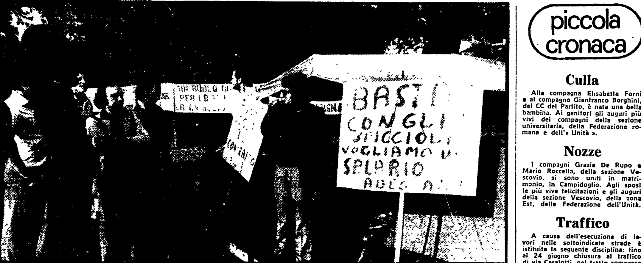
I lavoratori attorno alla tenda eretta dai braccianti a piazza Esedra
