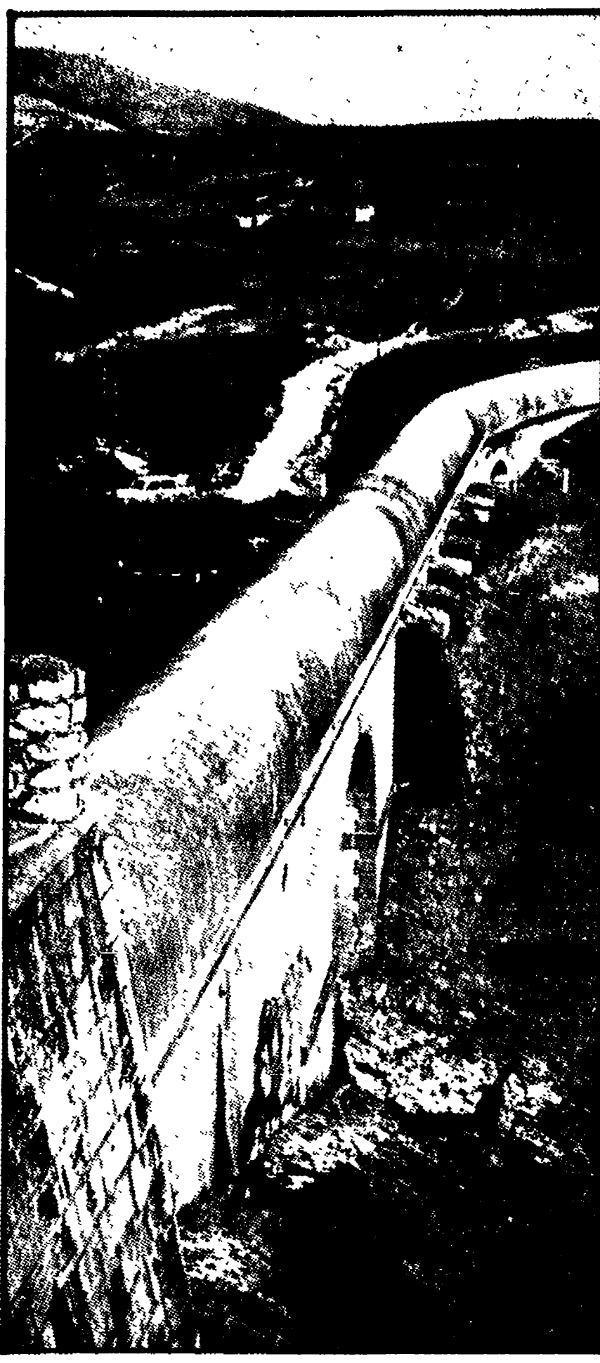
Un tratto della condotta dell'acquedotto Marcio
