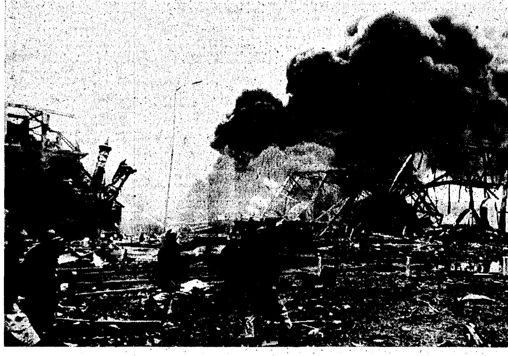
FLIXBOROUGH — Vigili del fuoco al lavoro sul luogo del disastro.
