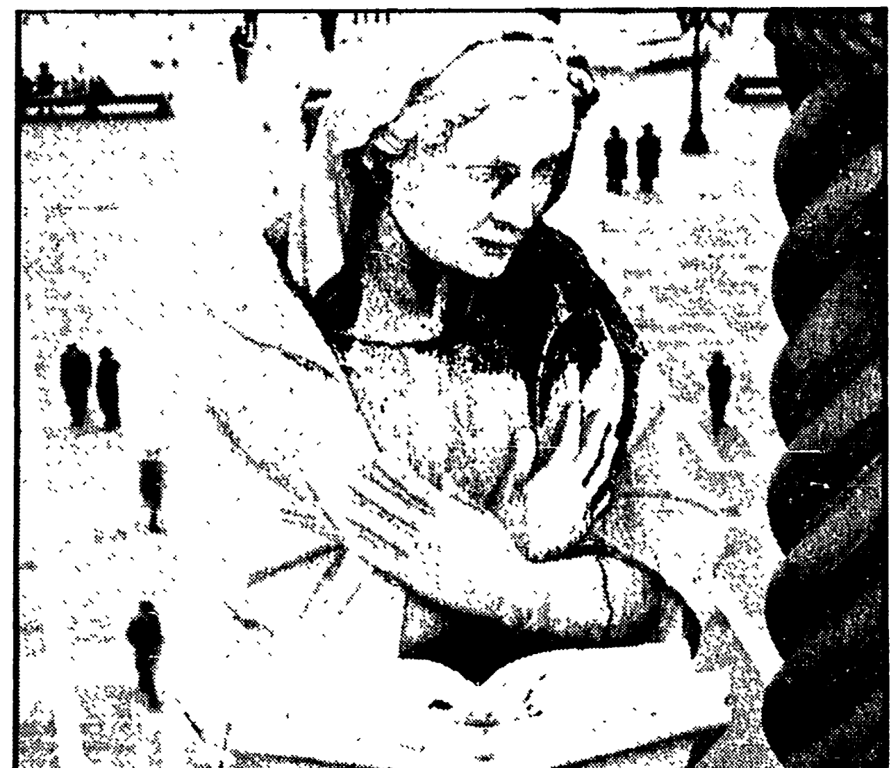
VENEZIA — Uno dei tanti aspetti che simboleggiano lo stato di rovina in cui versano i nostri monumenti. Qui, nella città il cui patrimonio artistico, architettonico e monumentale è minacciato più da vicino, sono mostrati gli effetti dell'inquinamento atmosferico (da notare le grandi macchie scure) su una statua di Madonna che sovrasta la basilica di San Marco
