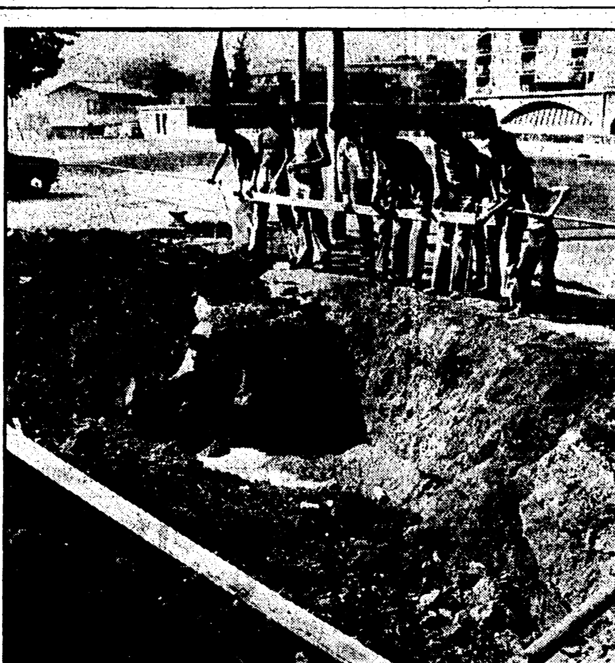
80 FAMIGLIE SENZ'ACQUA AL TUSCOLANO. Interrotta ormai da due giorni l'approvvigionamento idrico per più di 80 famiglie del quartiere Tuscolano a causa della rottura di una condotta. Il guasto, in largo Spartaco, è stato causato dai lavori di una ditta che sta installando un distributore di benzina. Scavando sotto il manto stradale il tubo che rifornisce la zona è stato forato. Per 80 famiglie e per i numerosi commercianti molli sono i disagi aggravati dal gran caldo di questi ultimi giorni.
