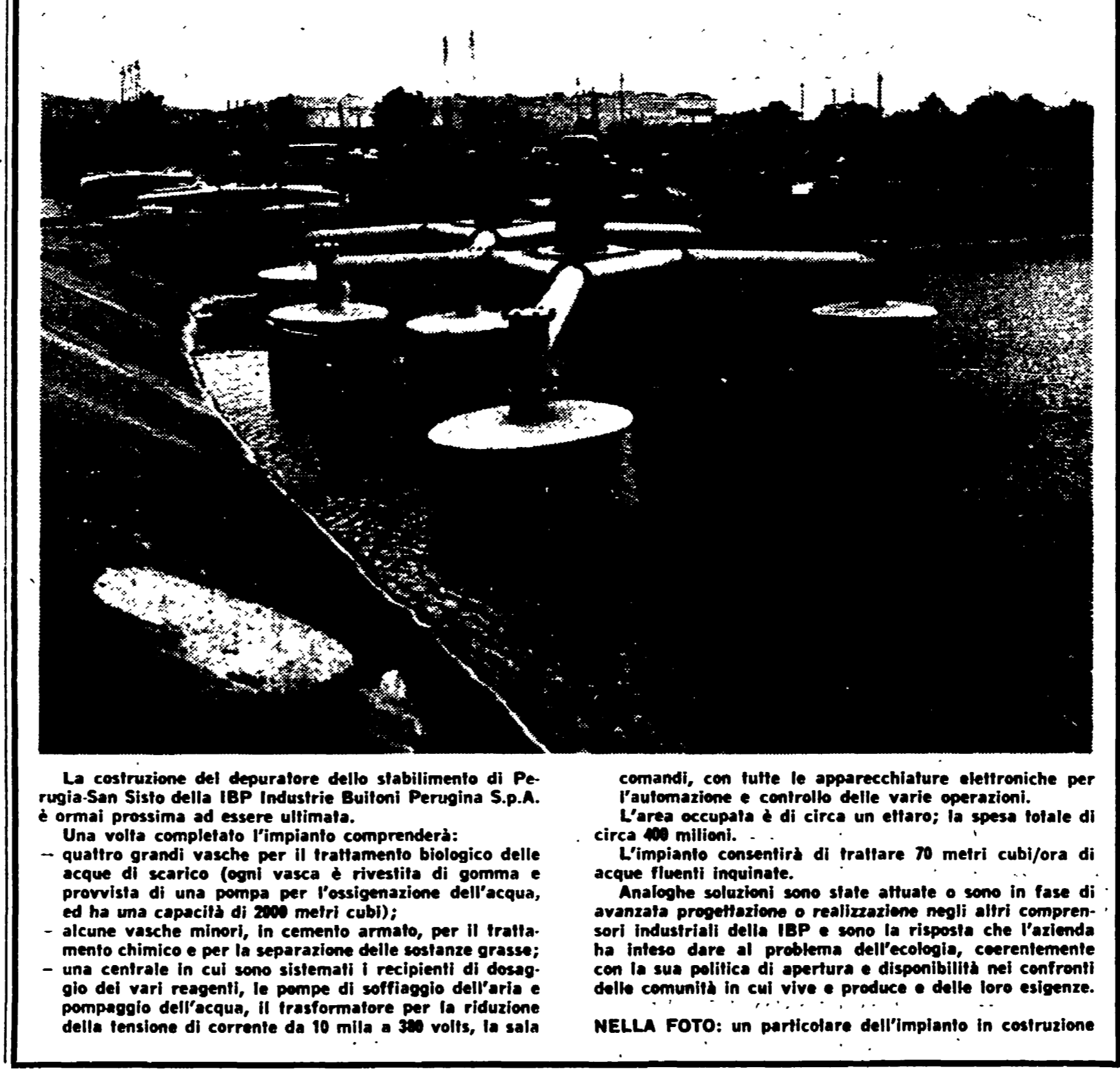
NELLA FOTO: un particolare dell'impianto in costruzione
