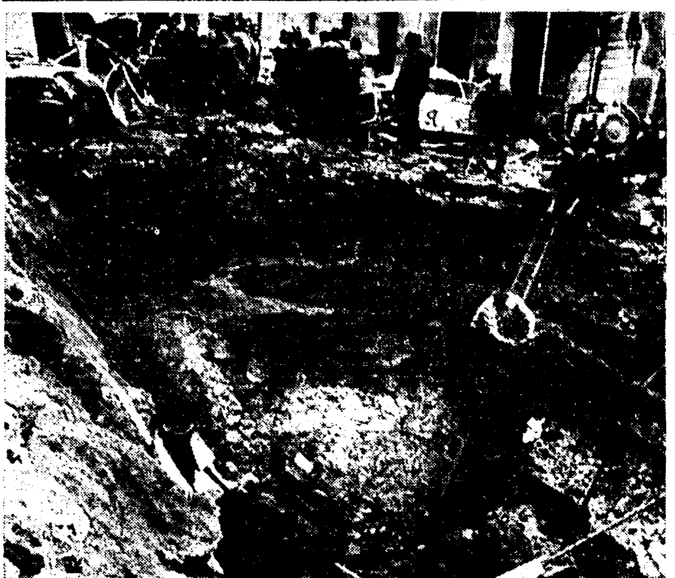
MADRID: UN'ESPLOSIONE DI GAS PROVOCA UN MORTO E 7 FERITI. Una fuga di gas sotterraneo, provocata probabilmente dalle correnti vaganti che hanno intaccato la conduttura, ha causato una violenta esplosione che ha sganciato un tratto di strada in quel momento percorso da un intenso traffico. Nell'esplosione un uomo è morto e sette persone sono rimaste ferite. Diverse auto sono andate distrutte. Nella foto: il cratere prodotto dall'esplosione.
