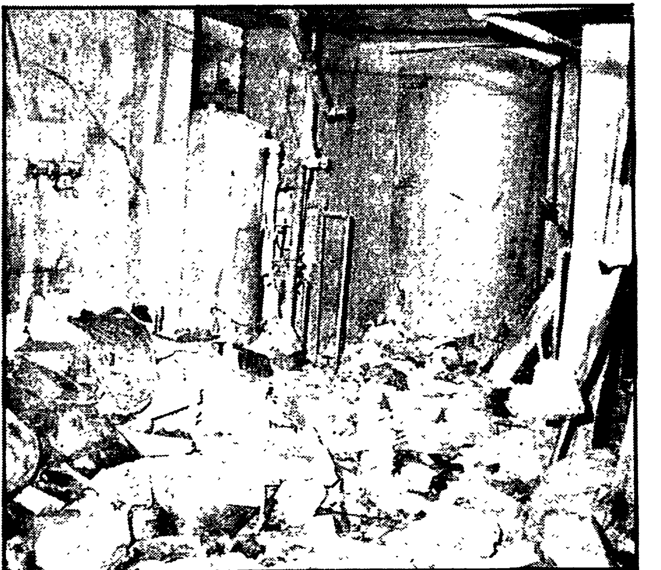
La lavanderia devastata dall'esplosione della caldaia
