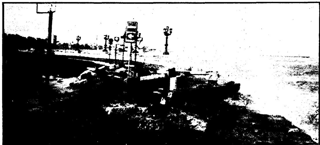
Un tratto del lungomare di Bari dissestato dalla violenta bufera che ha investito il basso Adriatico. Il maltempo ha provocato danni anche nel porto del capoluogo pugliese. Le mareggiate hanno colpito con una violenza inaudita anche quasi tutta la costa siciliana
