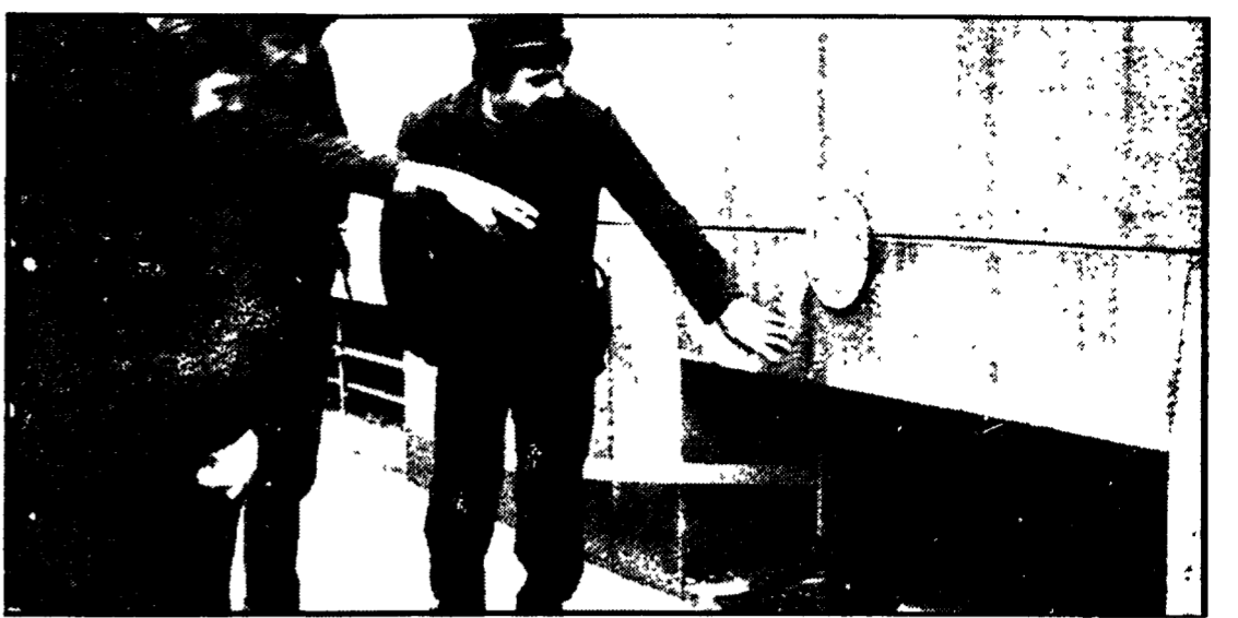
MILANO — Tecnici dell'ENEL osservano i danni provocati dalla bomba esplosa ieri notte al Palazzo di Giustizia
