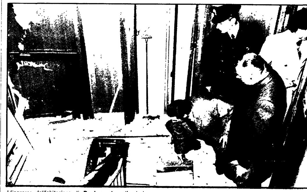
L'ingresso dell'abitazione di De Luca dopo l'esplosione
