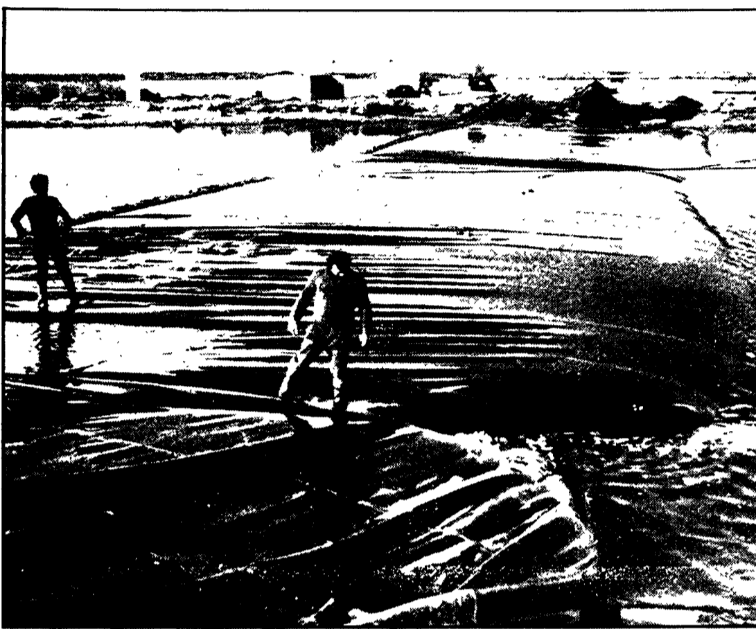
FERRARA — Una diga di gomma emerge da uno dei rami del Delta del Po. Gonfiata con acqua dovrebbe servire a controllare i flussi delle maree. Si tratta di sperimentare un metodo che dovrebbe essere poi destinato a regolare il livello delle acque a Venezia
