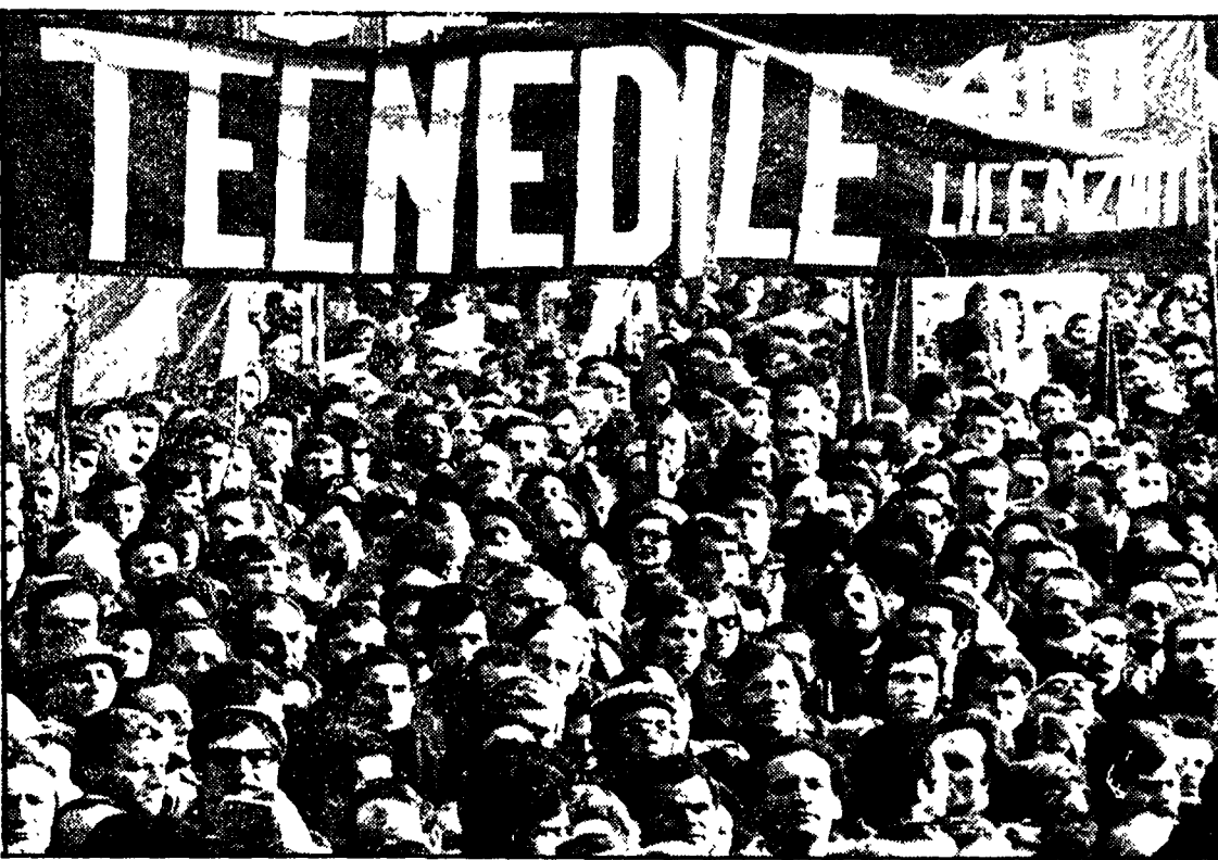
Completamente deserti ieri i cantieri edili della zona Appia-Tuscolana ed EUR, dalle 9 alle 12, ora in cui era stato indetto lo sciopero in difesa dell'occupazione. I lavoratori si sono recati in corteo (come si vede nella foto) davanti ai cantieri della Tecnedit, che costruisce per conto dell'immobiliare Beni e ha licenziato oltre 400 persone. Nel corso della manifestazione hanno preso la parola Porcheddu, della FLC e Belli della FILLEA. Nei prossimi giorni ci sarà un incontro all'ufficio del lavoro con l'ACER, sul problema della Tecnedit
