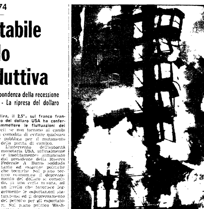
SALVI PER UN PELO Un furioso incendio ha devastato negli USA ad Atlantic City, lunedì scorso, un edificio appartenente alla US Embassy. Seguendo ai danni riportati si è letteralmente sbriciolato. Le 300 persone che vi abitavano sono state messe in salvo; solo sette di esse, insieme a sette vigili del fuoco, sono rimaste ferite. Nella foto si è ancora potuto accertare sulle cause dell'incendio, che non si esclude sia di origine dolosa.
