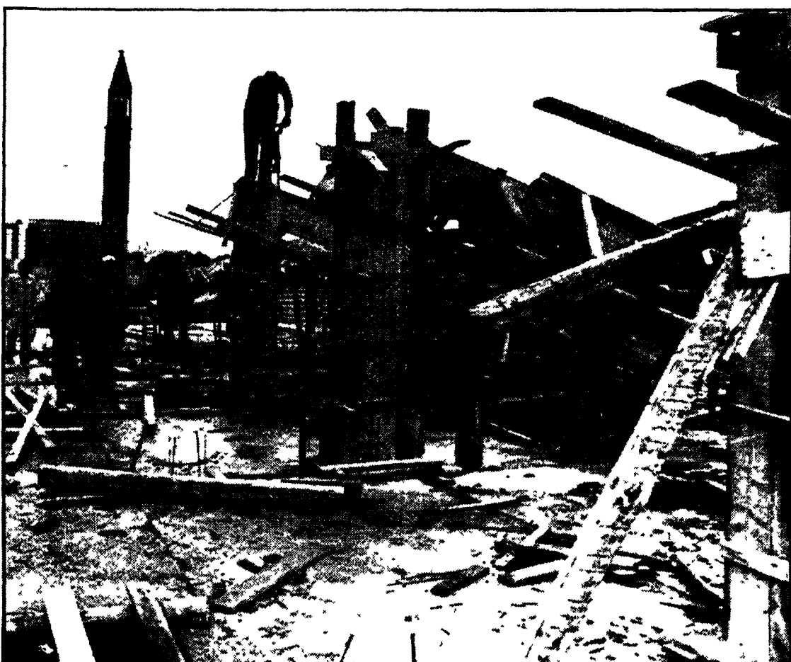
Alcuni operai mentre demoliscono uno dei palazzi abusivi in via Mantegna
