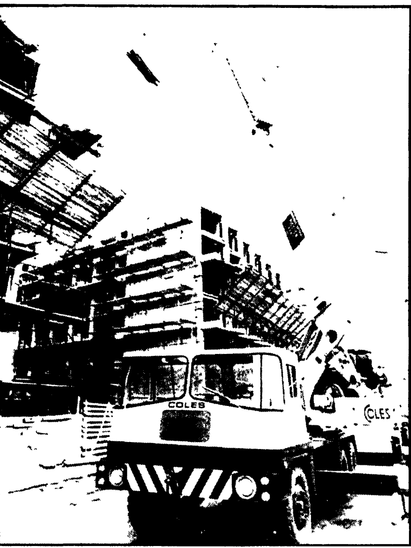
Un'autogrù adibita alla demolizione dei palazzi di Armellini.
